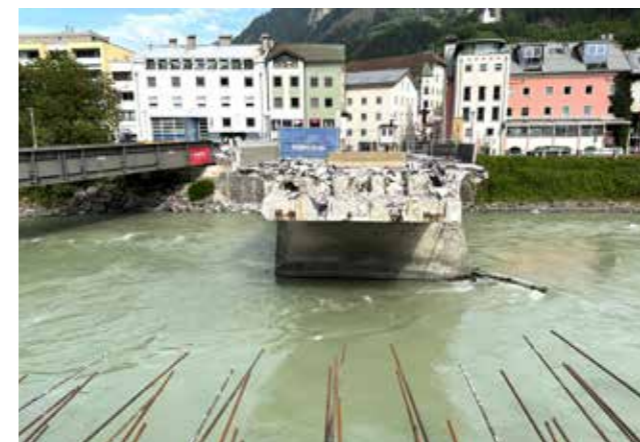
Hier ein Blick vom neu errichteten Brückenteil auf den noch bestehenden alten Teil der Steinbrücke, der im Verlauf der jetzt beginnenden Baustufe 2 abgetragen wird.
