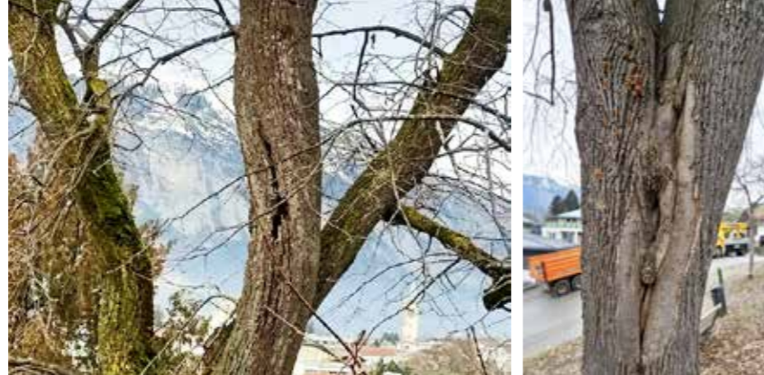
Faulstellen, Hohlräume, Druckzwiesel, Totholz und beschädigte Wurzeln sind Gefahren, die man erkennen muss.
